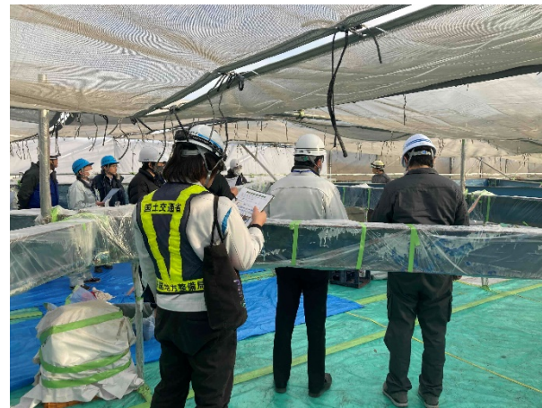
現場実習（阿波麻植大橋）
