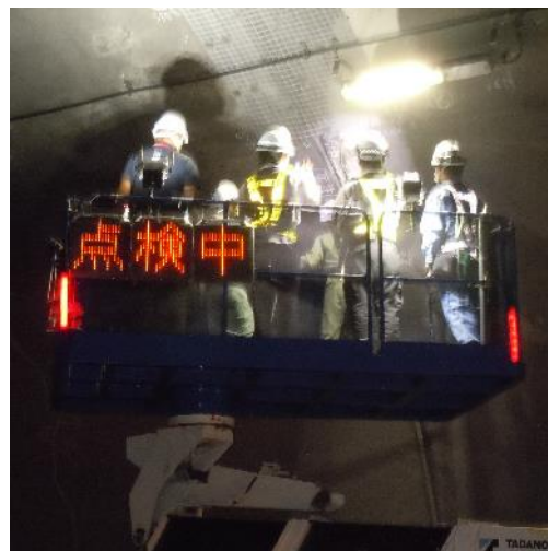
現地実習（打音点検状況）
