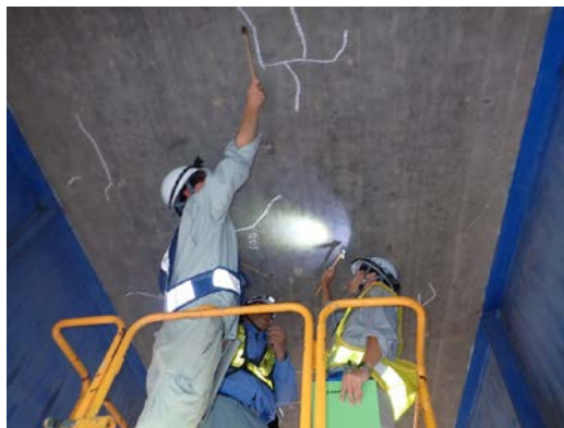
リフト車で近接目視点検
