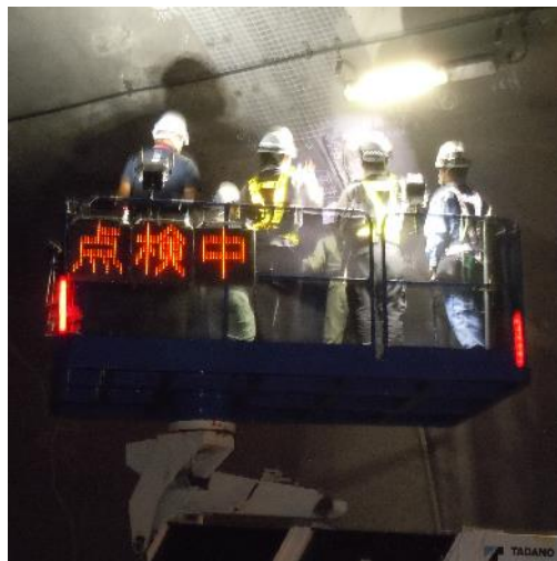
現地実習（打音点検状況）
