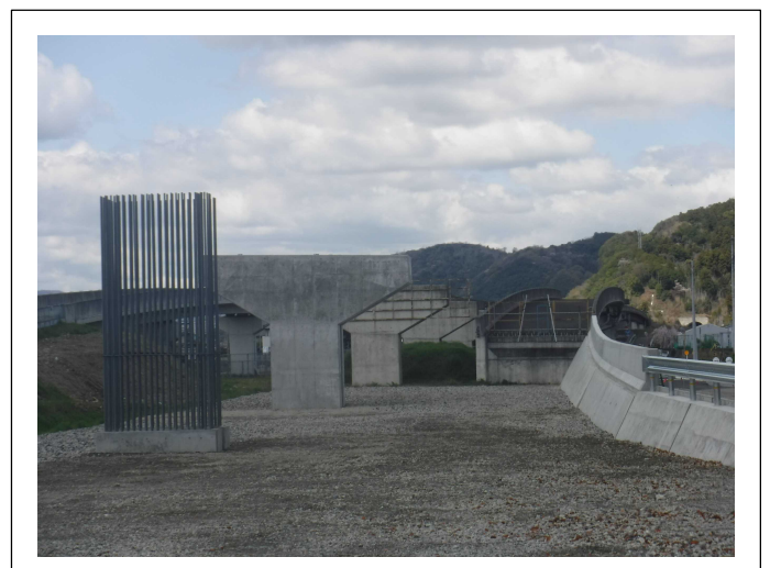
下部工を施工しています。
