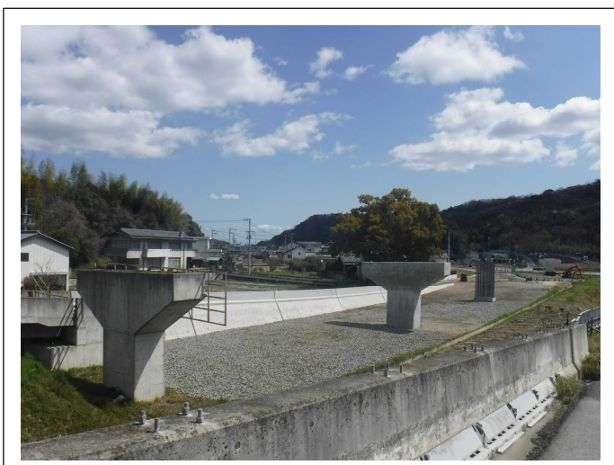
下部工を施工しています。
