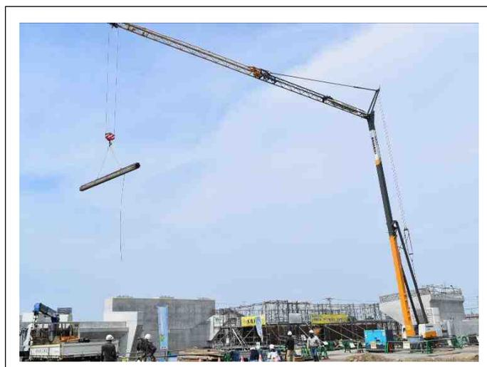
定置式水平ジブクレーンを使用した施工状況です。
