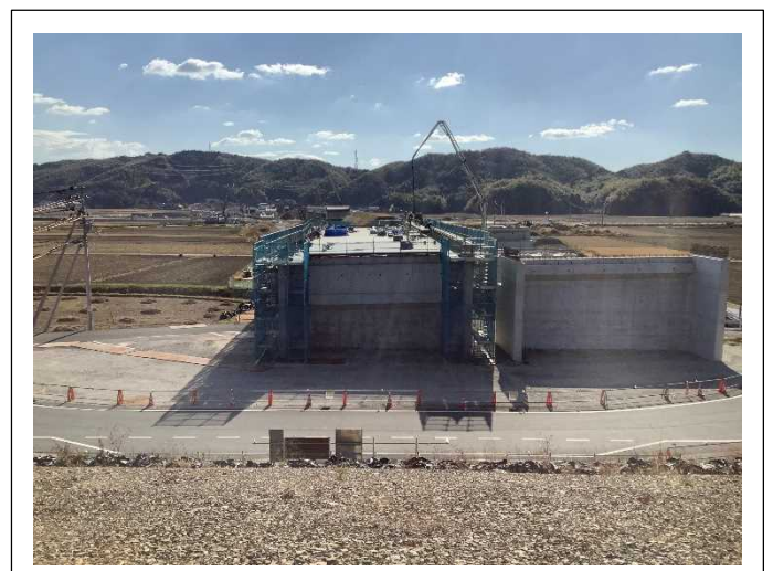
上部工を施工しています。
