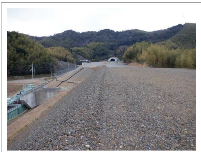
盛土工を施工しています。
