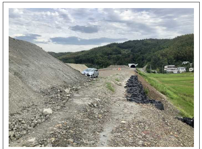
盛土工の状況です。
