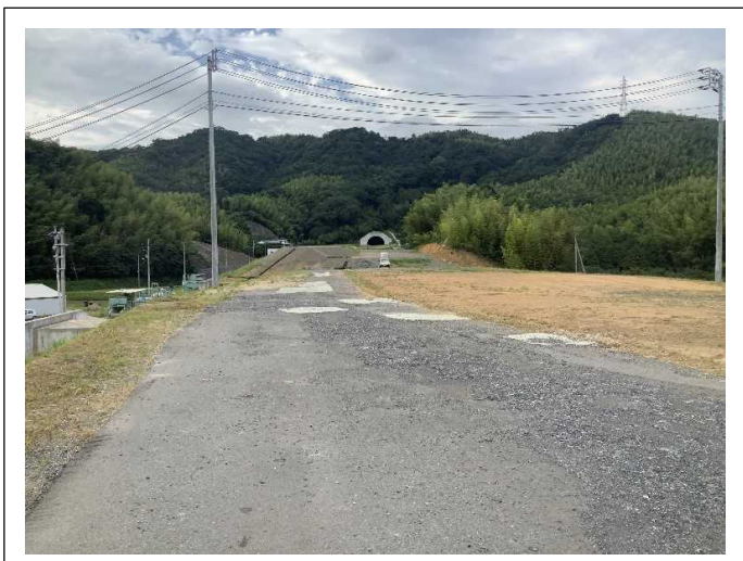
盛土工の状況です。
