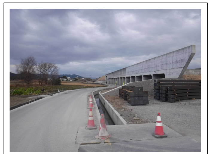
側道部の状況です。
