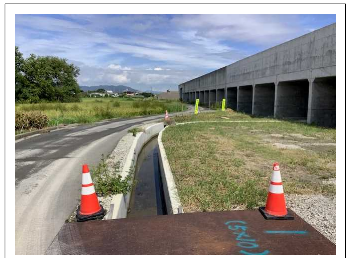
側道部の状況です。
