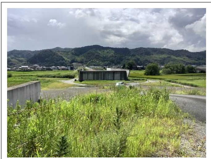
函渠工の状況です。
