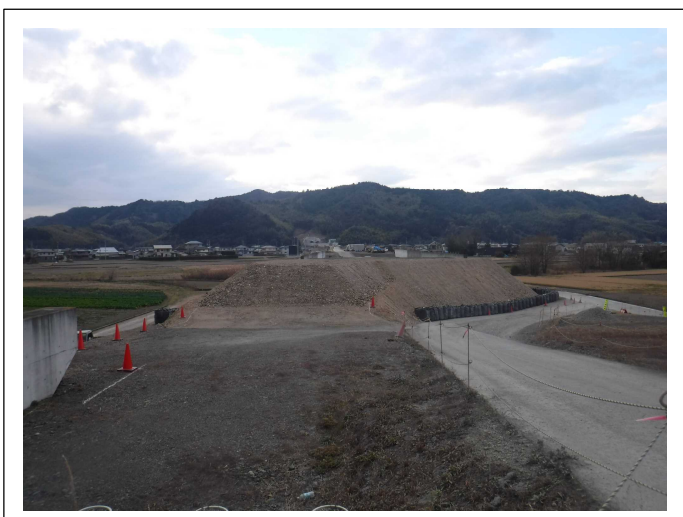
盛土工の状況です。
