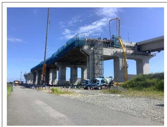
上部工を施工しています。
