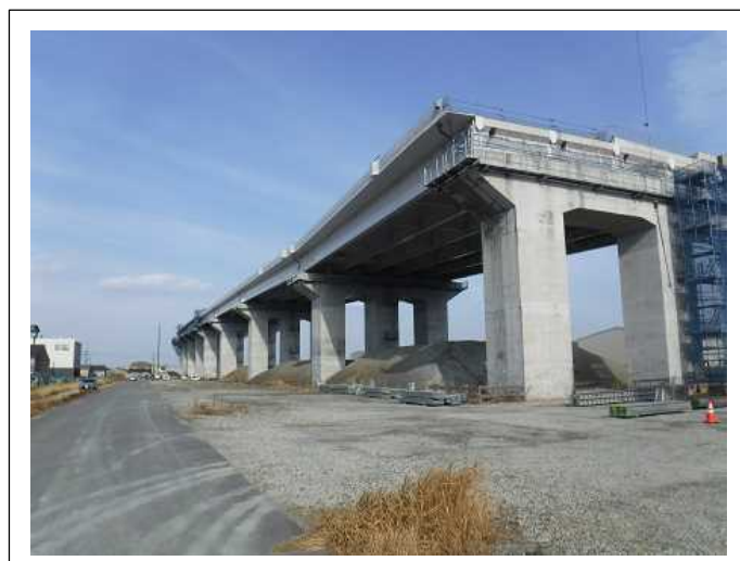
上部工を施工しています。
