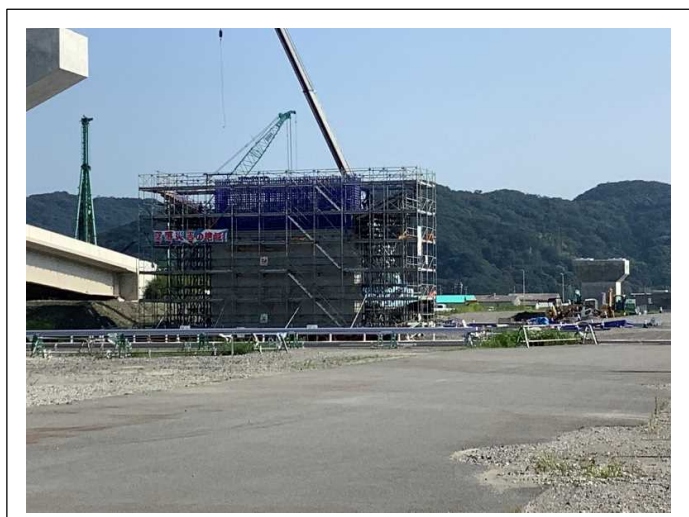
下部工を施工しています。
