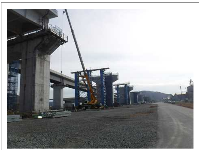
上部工を施工しています。
