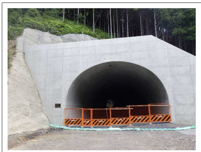
トンネル坑門工の状況です。
