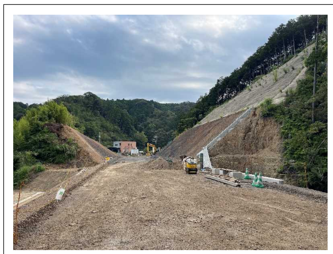
切土工を施工しています。
