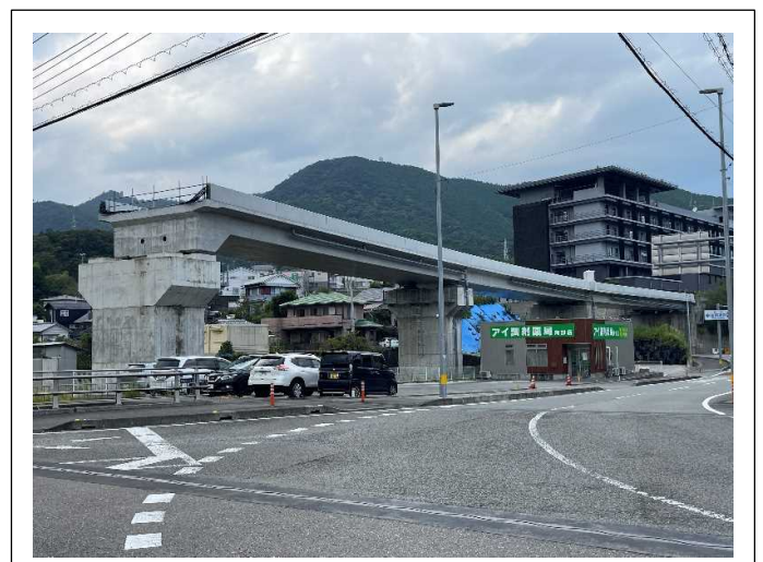
上部工の状況です。
