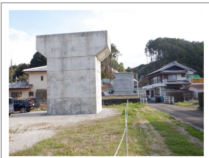
下部工の状況です。
