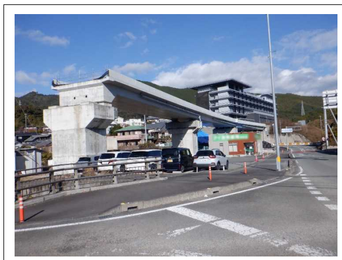
上部工の状況です。
