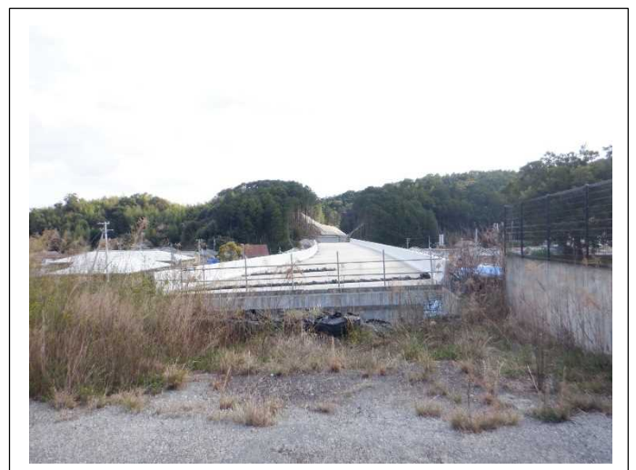
上部工の状況です。
