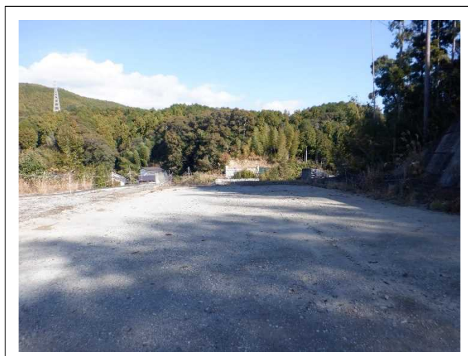
道路土工の状況です。
