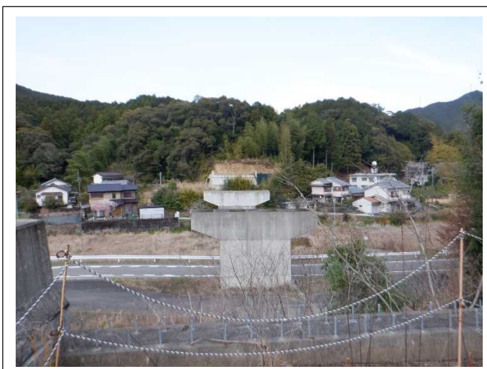
下部工の状況です。
