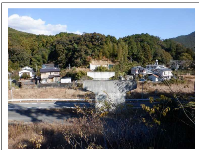
下部工の状況です。
