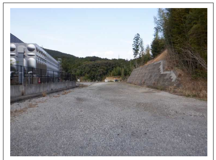
道路土工の状況です。
