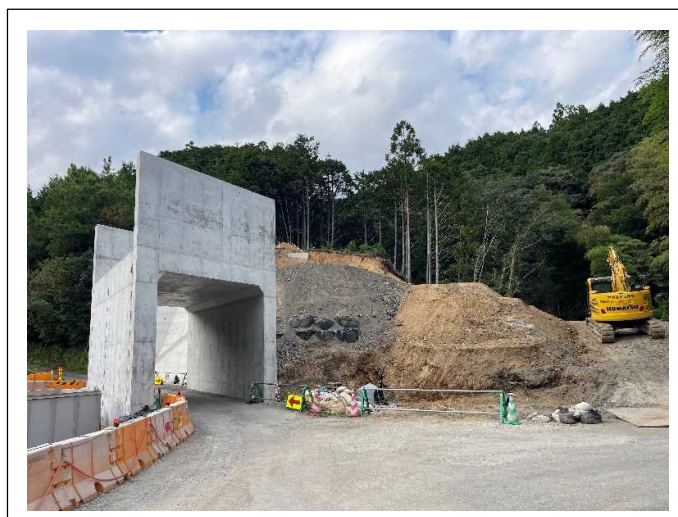
函渠工、切土工を施工しています。
