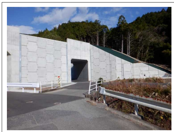
函渠工、切土工を施工しました。
