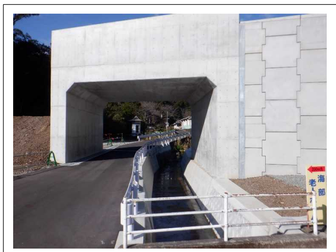
函渠工、仮水路工を施工しました。
