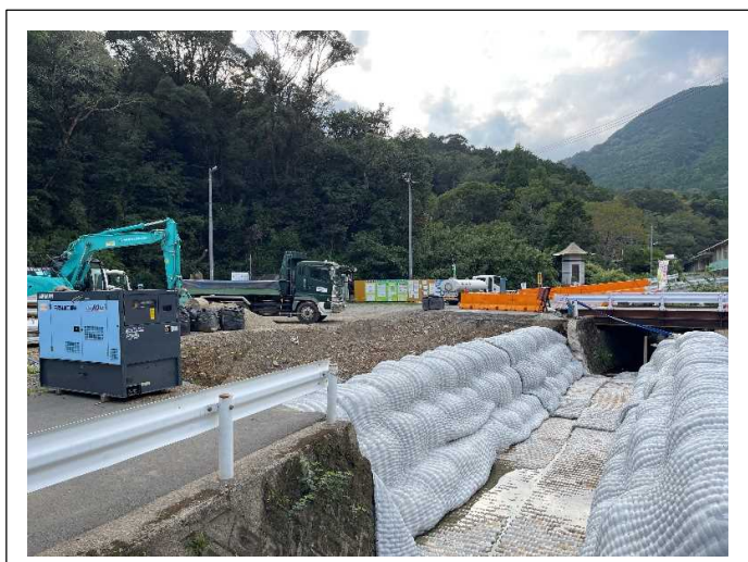
函渠工、仮水路工を施工しています。
