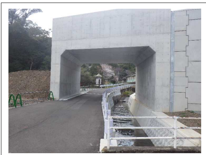
函渠工、仮水路工を施工しました。
