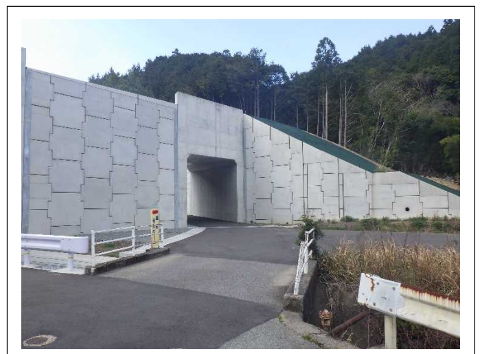
函渠工、切土工を施工しました。
