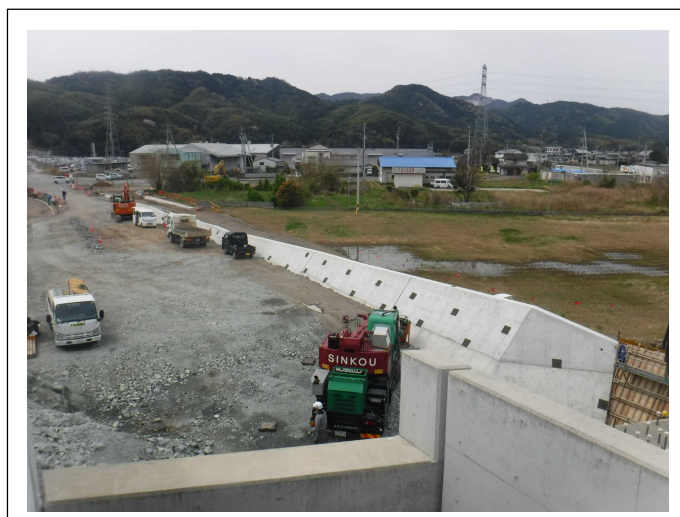
擁壁を施工しています。
