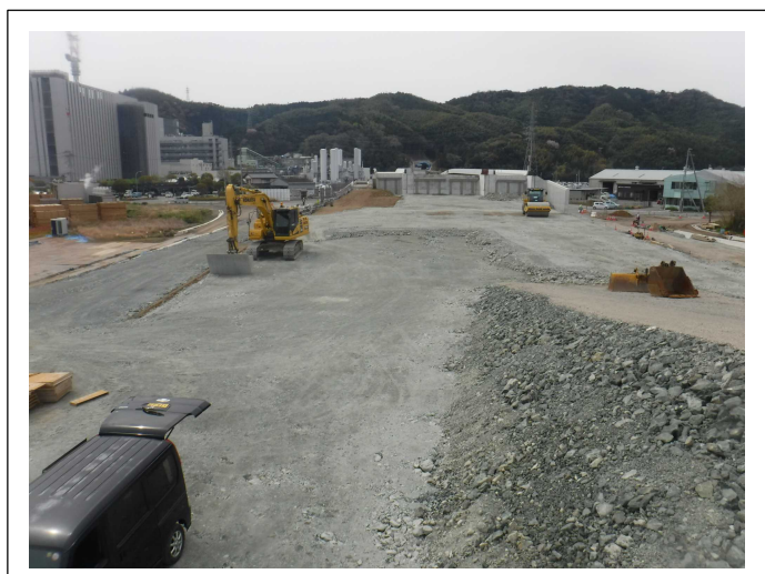
盛土を施工しています。
