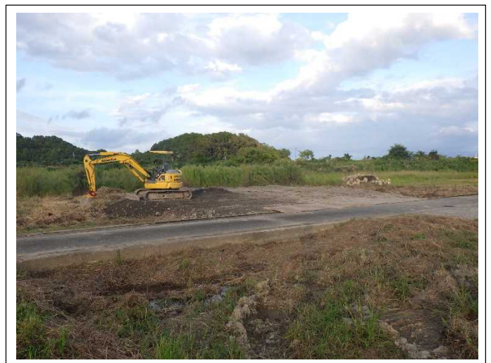
作業ヤードを施工しています。
