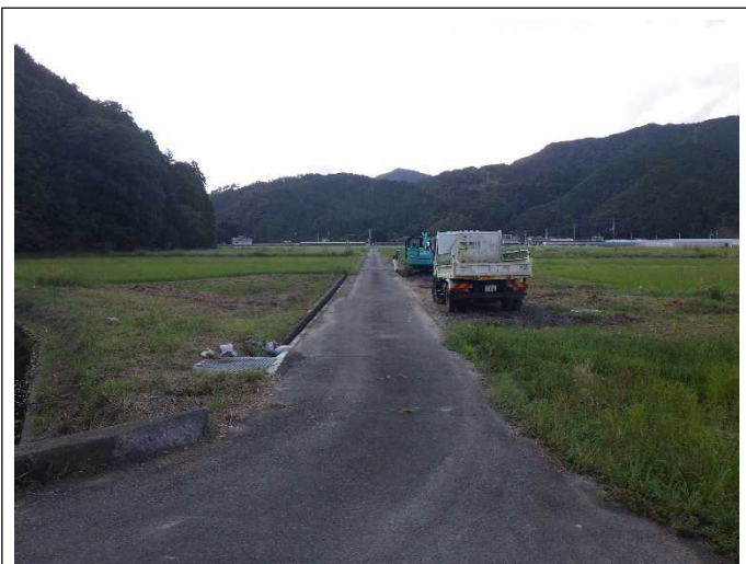
工事用道路施工箇所です。
