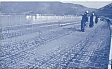
鉄筋を組み上げた後、膨張剤を混入したコンクリートを流し込みます。
