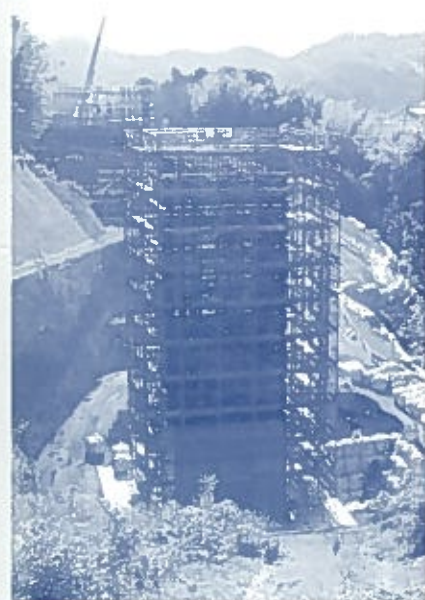
橋脚の基礎工事。鉄筋を組み上げ、コンクリートで固めます。
