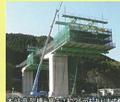
木岐高架橋、高さは約25mもあります。
