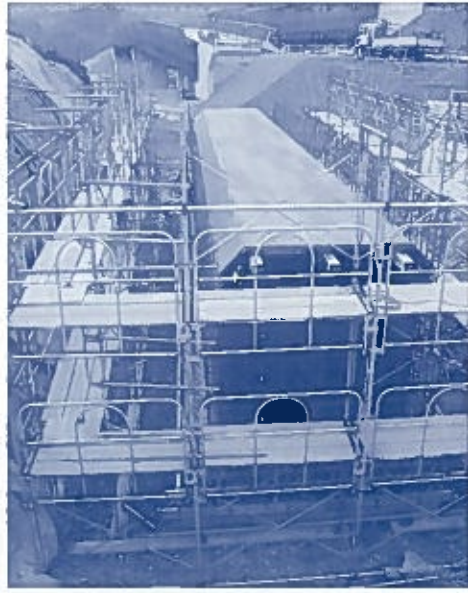
道路下を通行できるよう埋設される小型のトンネル
