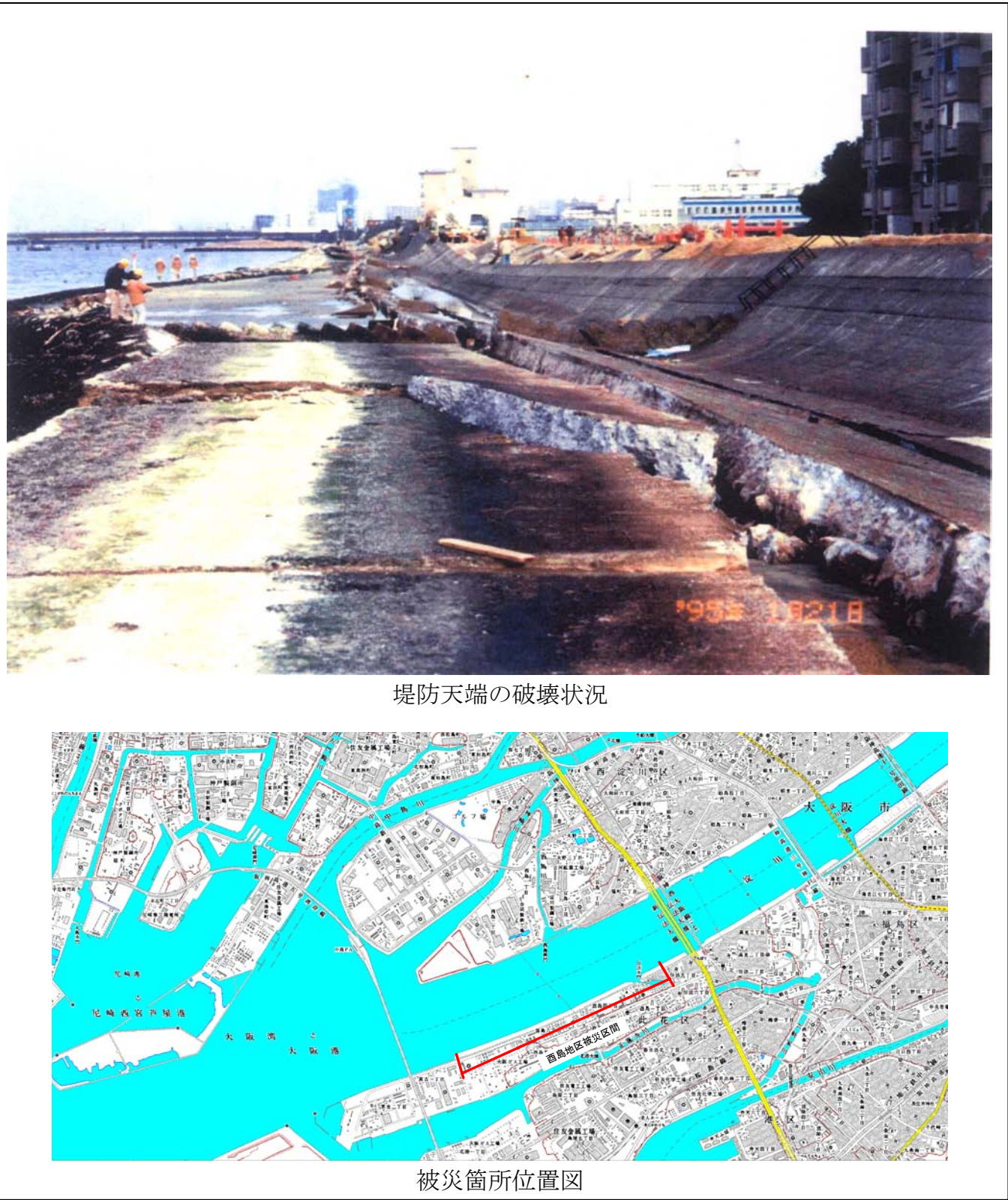
図 2.8 地震による被災事例 平成 7 年兵庫県南部地震（淀川左岸西島地区）
