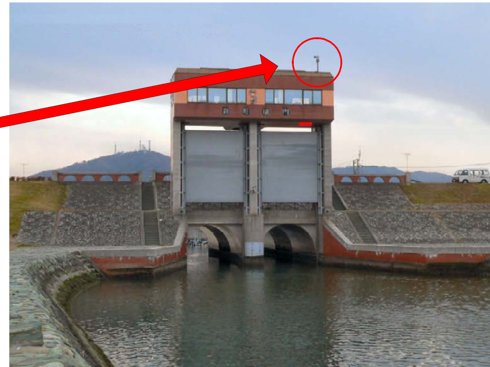
新町樋門：吉野川右岸5k0(樋門上部に設置されたCCTV)
