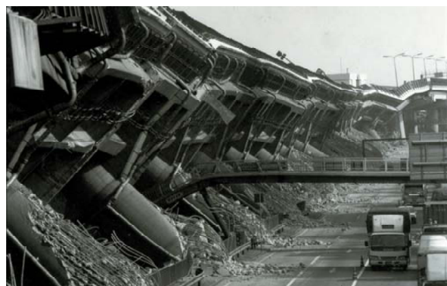
平成7年兵庫県南部地震により倒壊した阪神高速道路
