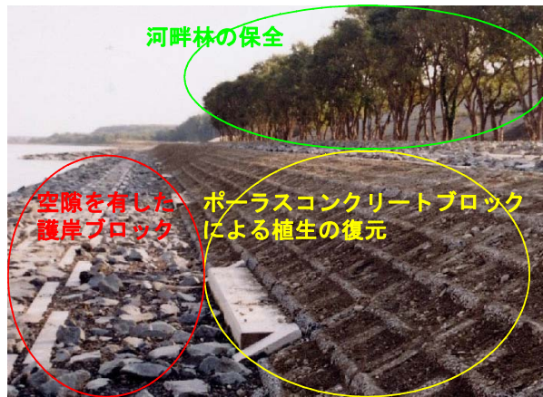
施工直後 (平成13年3月)
