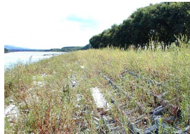
施工2年後 (植生の繁茂状況)
