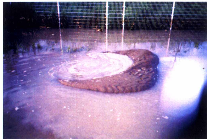
台風23号 穴吹町穴吹（R42k/4付近）
