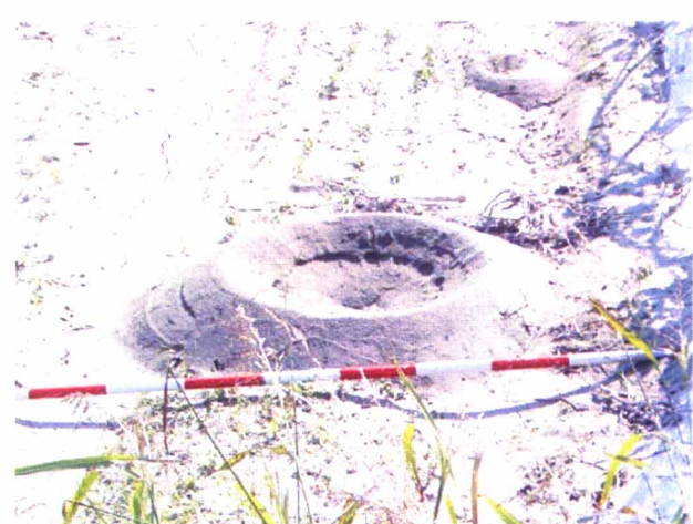
台風23号（漏水） 石井町（R15k/6付近）
