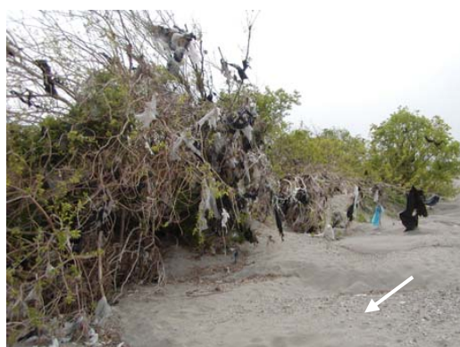
写真 4.2 伐採区の高水敷上の状況
