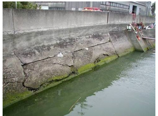
【旧堤の老朽化】
