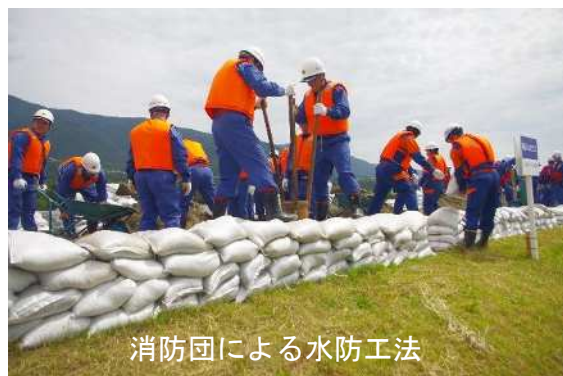
自主防・防災士・高校生による土のう作り
