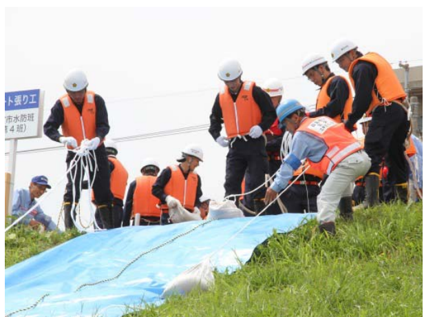
▲応急型シート張り工
