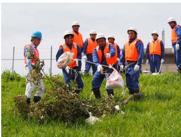
▲応急型木流し工
