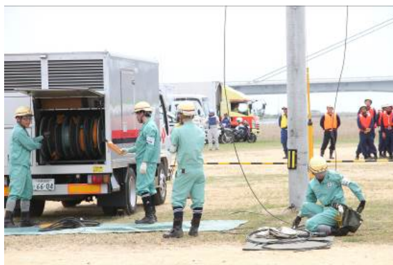
▲配電線復旧訓練
