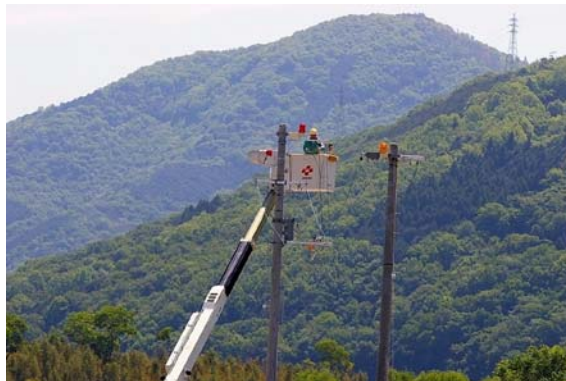
四国電力による配電線の復旧訓練
