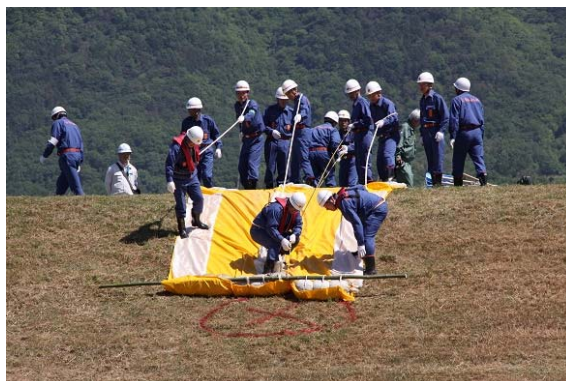
東みよし町水防班による水防マット工
