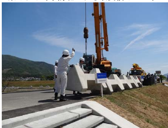
徳島県建設業協会による積みブロック工
