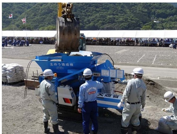
国土省水防班等による土のう造成機による 土のう作り
