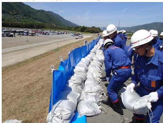
井川町水防班・山城町水防班・東みよし町水防班による改良積み土のう工
