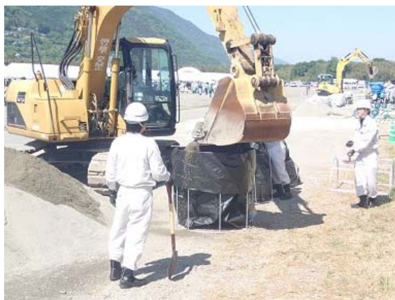
徳島県建設業協会による大型土のう作り
