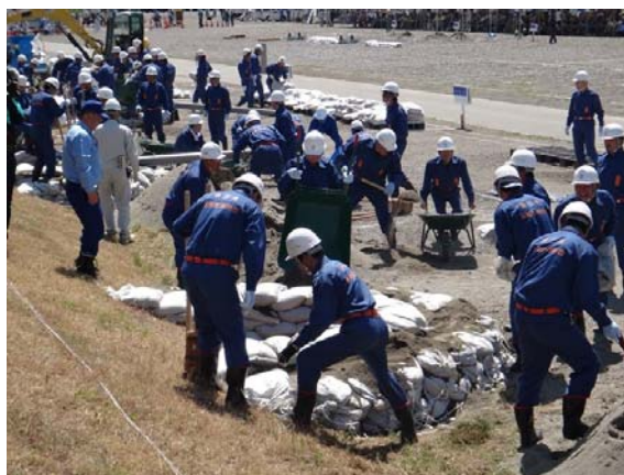
協町水防班・穴吹水防班による月の輪工
