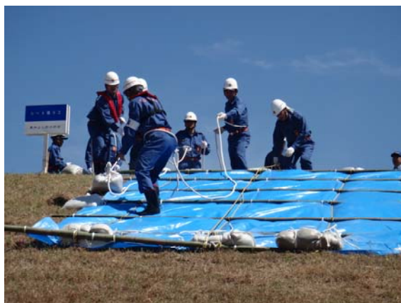
東みよし町水防班・半田町水防班による シート張り工
