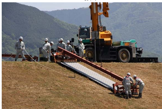
徳島県建設業協会によるブロック張り工
