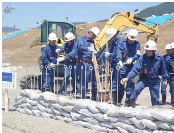
木屋平水防班・一宇水防班・西祖谷水防班・東祖谷水防班による積み土のう工
