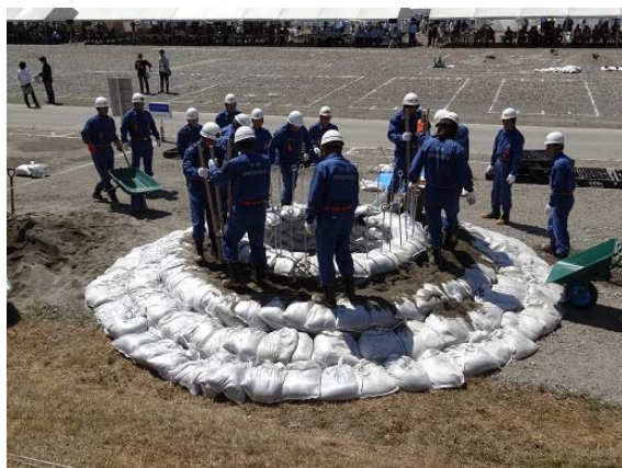
貞光水防班による釜段工
