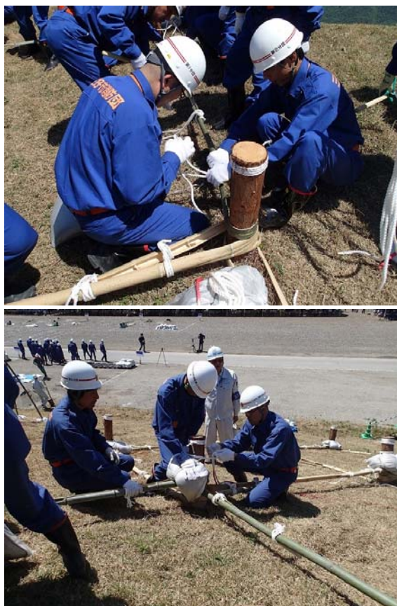
三野町水防班による籠止め工
