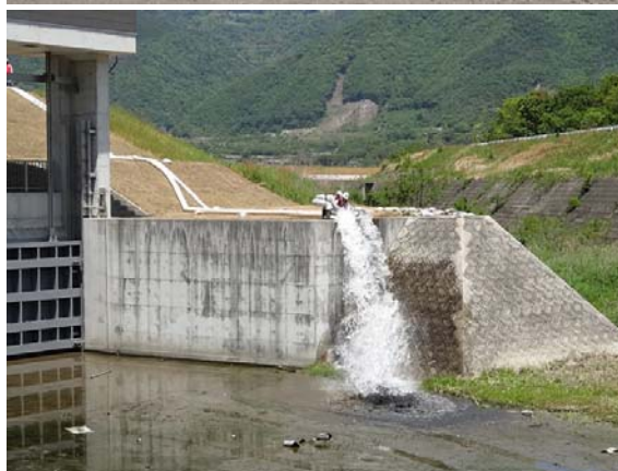
排水ポンプ車による内水排除訓練
