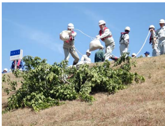
徳島県水防班による木流し工
