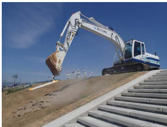
国交省水防班等による捨て土のう工
