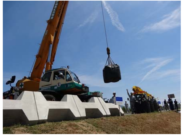
徳島県建設業協会による大型土のう工
