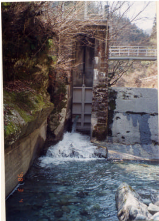
片川取水ダム
