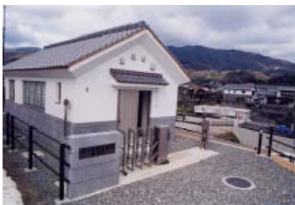
遠方操作室と操作盤
