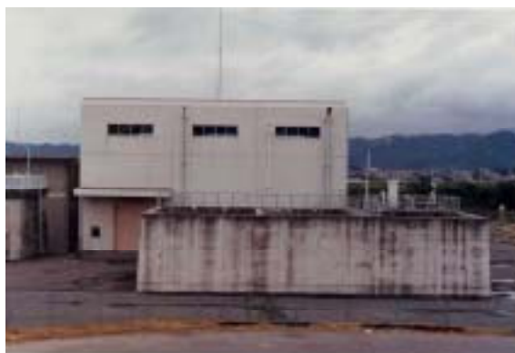
排水機場全景
