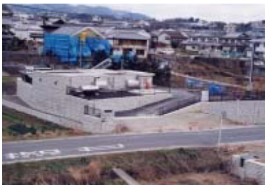
排水機場全景
