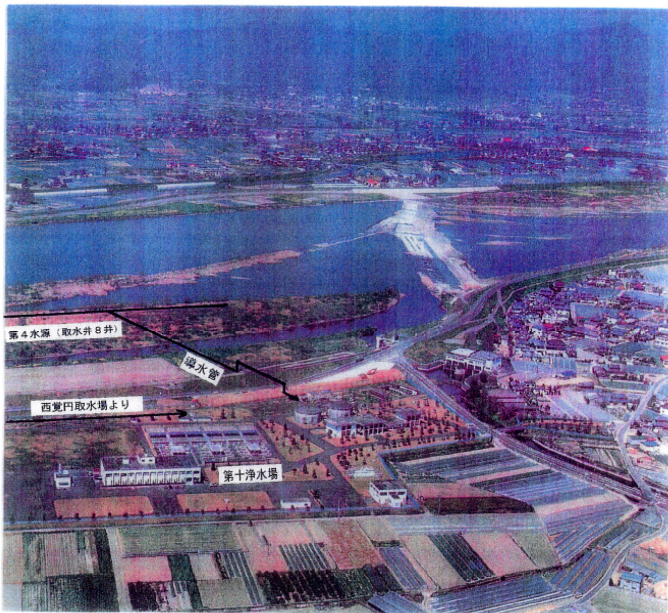
第4水源及び第十浄水場全景
