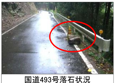
国道493号落石状況
