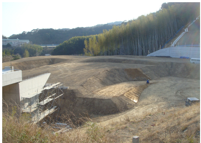
②改良工事が進む大浦地区 (H25. 3. 12撮影)
