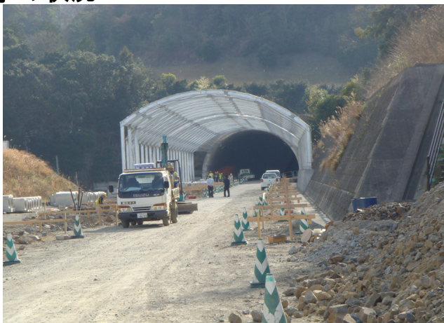
①改良工事が進む西分地区 (H25. 3. 12撮影)
