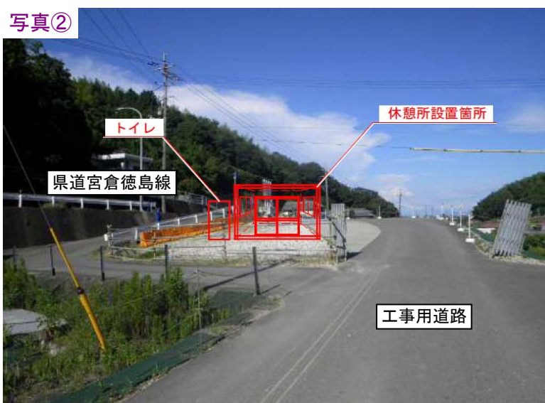
休憩所設置箇所
