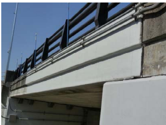
剥落防止シート設置
