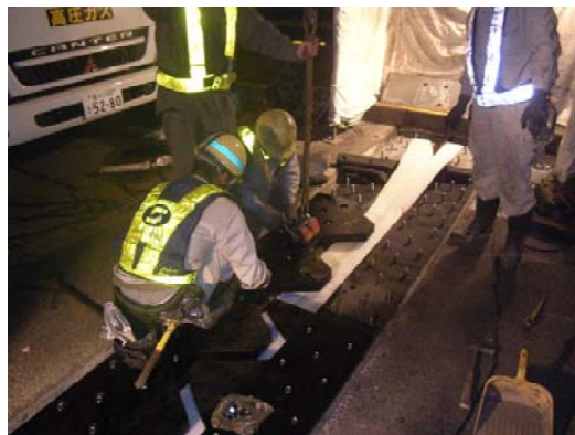
伸縮装置取り替え
