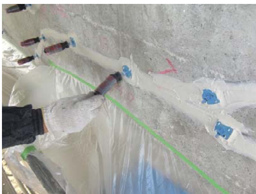
樹脂注入（ひび割れ補修）
