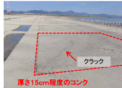
仮設道路(中詰めコンクリート)
