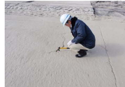
打音調査状況
