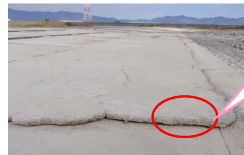
仮設道路(中詰めコンクリート)
