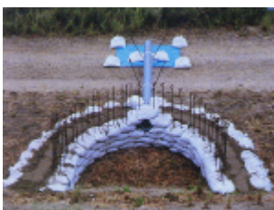
漏水対策：月の輪工
