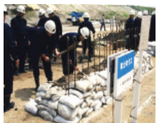
越水対策：積み土のう工
