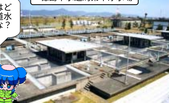
徳島市水道局第十浄水場
