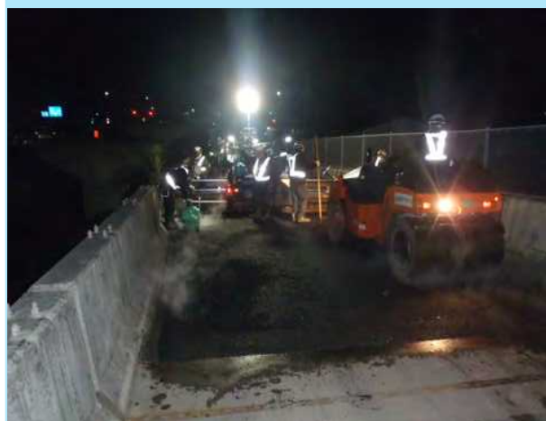
舗装補修工事
