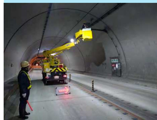
電気通信設備点検
