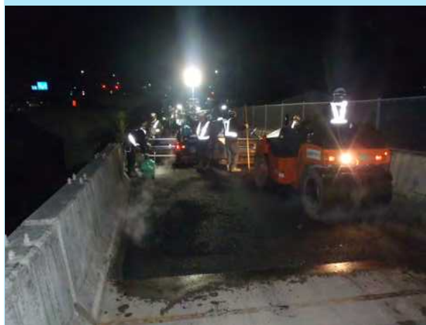
舗装補修工事
