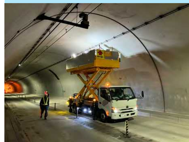
電気通信設備点検
