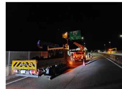
設備保守作業
