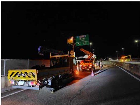
設備保守作業
