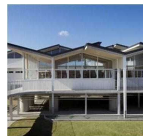
高床化による浸水対策
