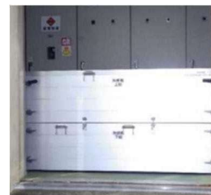
止水壁の設置
