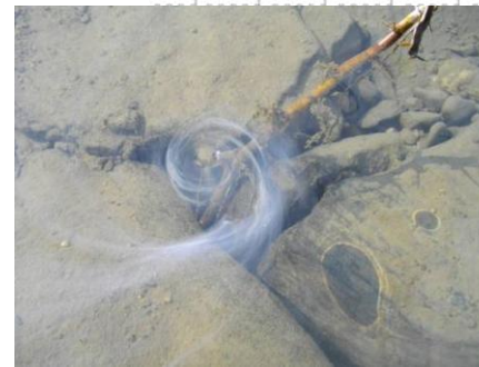
平成22年度調査で確認された 渦巻流入箇所
