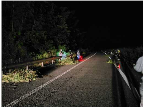
道路維持作業 (除草等)
