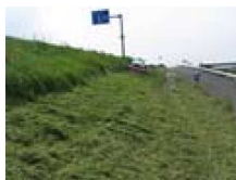
除草作業の状況写真
