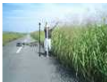
堤防の草の状況写真
