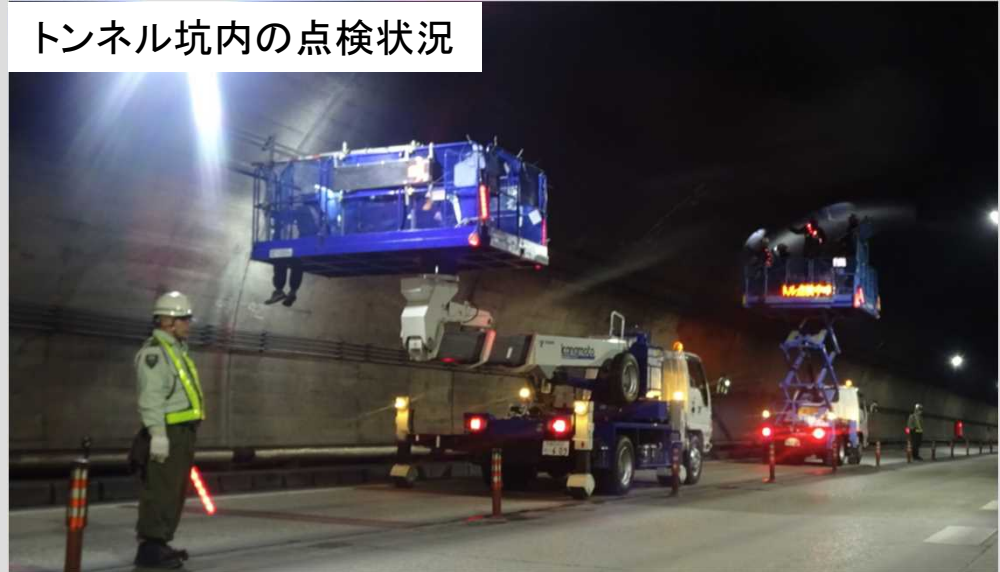
CCTVカメラの点検状況
