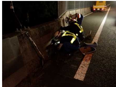
道路維持作業 (除草等)
