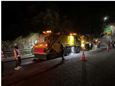
舗装修繕工事
