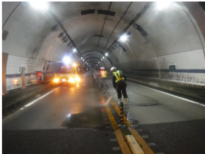
維持作業(路面清掃)
