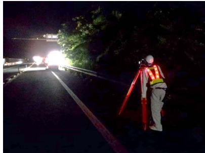
調査作業(起工測量)
