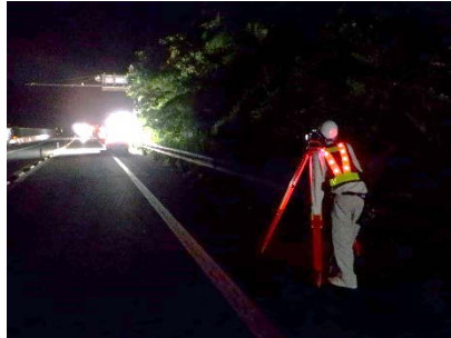
調査作業(起工測量)
