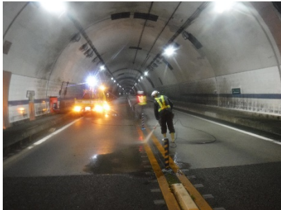
維持作業(路面清掃)
